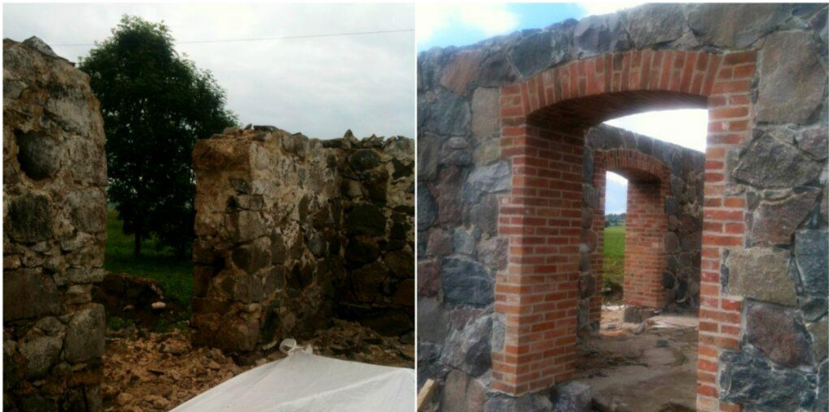
Maakivihoone müüritööd Laekveres – enne ja pärast silluse ja müüritise taastamist. Foto: Helari Sirelpuu
