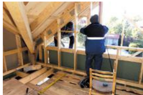
KATUS JA PÖÖNING SOOJAPIDAVAKS: MV Ehituse töömeestel käib kiire töö, et enne pakase tulekut saaks Merivälja eramaja korraliku soojustatud katuse koos kõigi vajalike aluskihtide ja tuulutuskanalitega. (Arno Saar)
